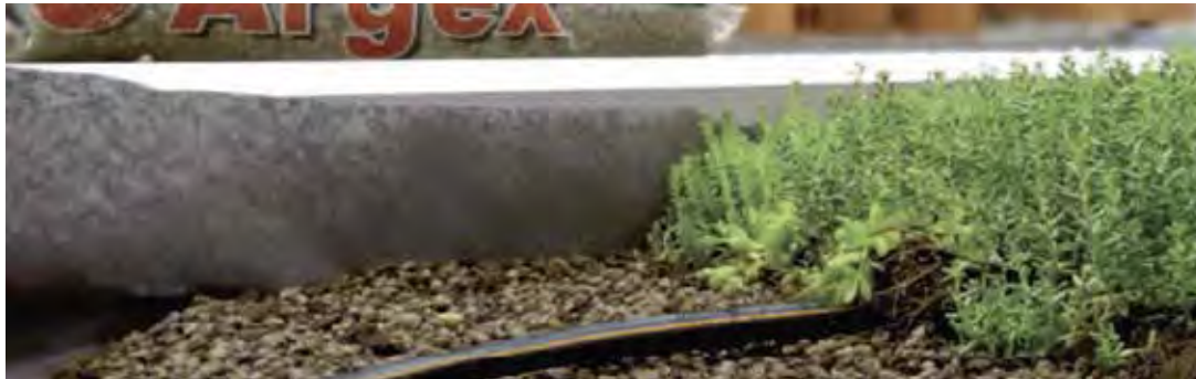
Aplicació de l'argila expandida Argex® en cobertes enjardinades.
